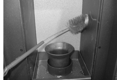
Fig. 33 - Limpieza con escobilla
