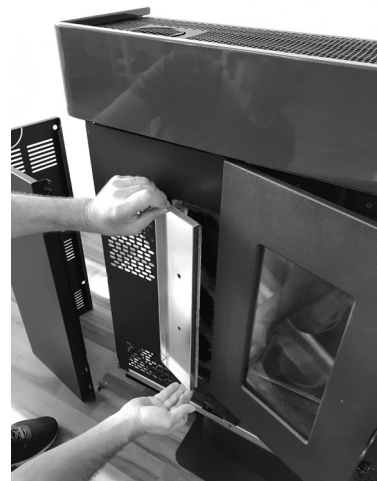
Fig. 36 - Desmontaje del panel de inspección
