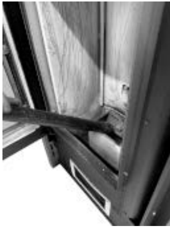
Fig. 35 - Limpieza alojamiento brasero
